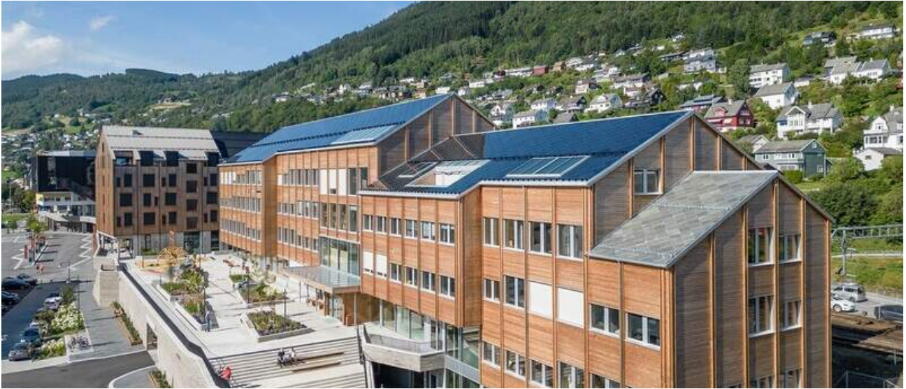
Kontorbygget Knutepunktet ligger rett ved Voss stasjon og ble ferdigstilt i begynnelsen av 2022. Foto: Hundven Clements Photography
