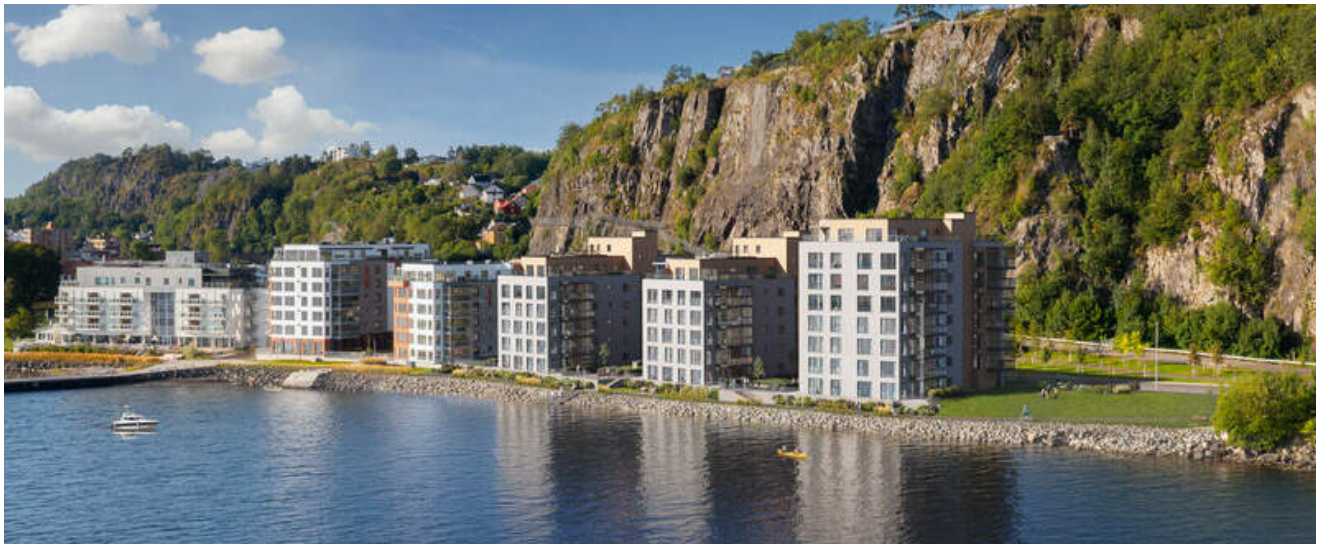
Boligprosjektet Strandholmen rett ved stasjonen i Holmestrand. Første byggetrinn inkludert parkeringskjeller er nylig igangsatt. Prosjektet omfatter tre boligbygg med til sammen 70 leiligheter. Illustrasjon: Link Arkitektur.
