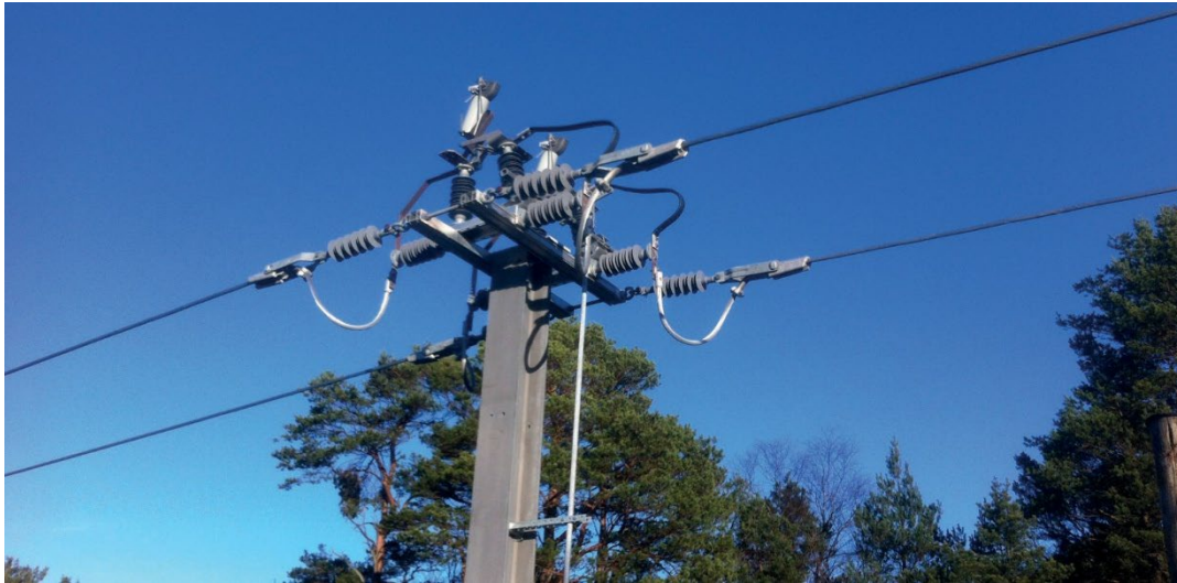
Figur 17.22 Seksjonering av PL og NL med 2-polet lastskillebryter
