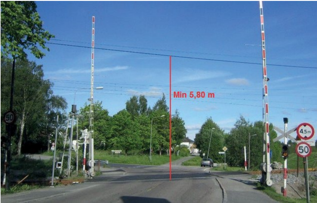
Figur 19.3 Illustrasjon av fremføring av returstrømledning over planovergang
