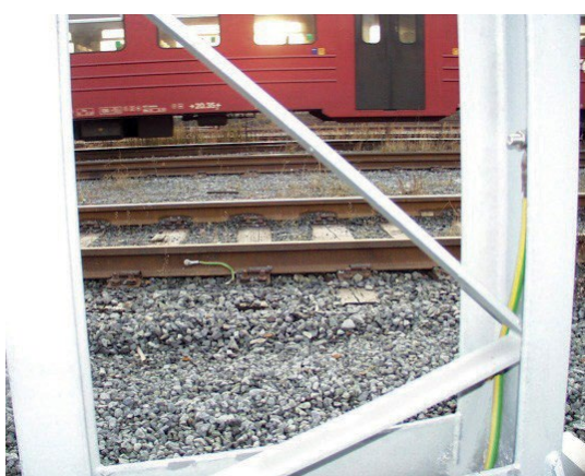
Figur 21.39 Riktig utførelse ved utjevning av mast
