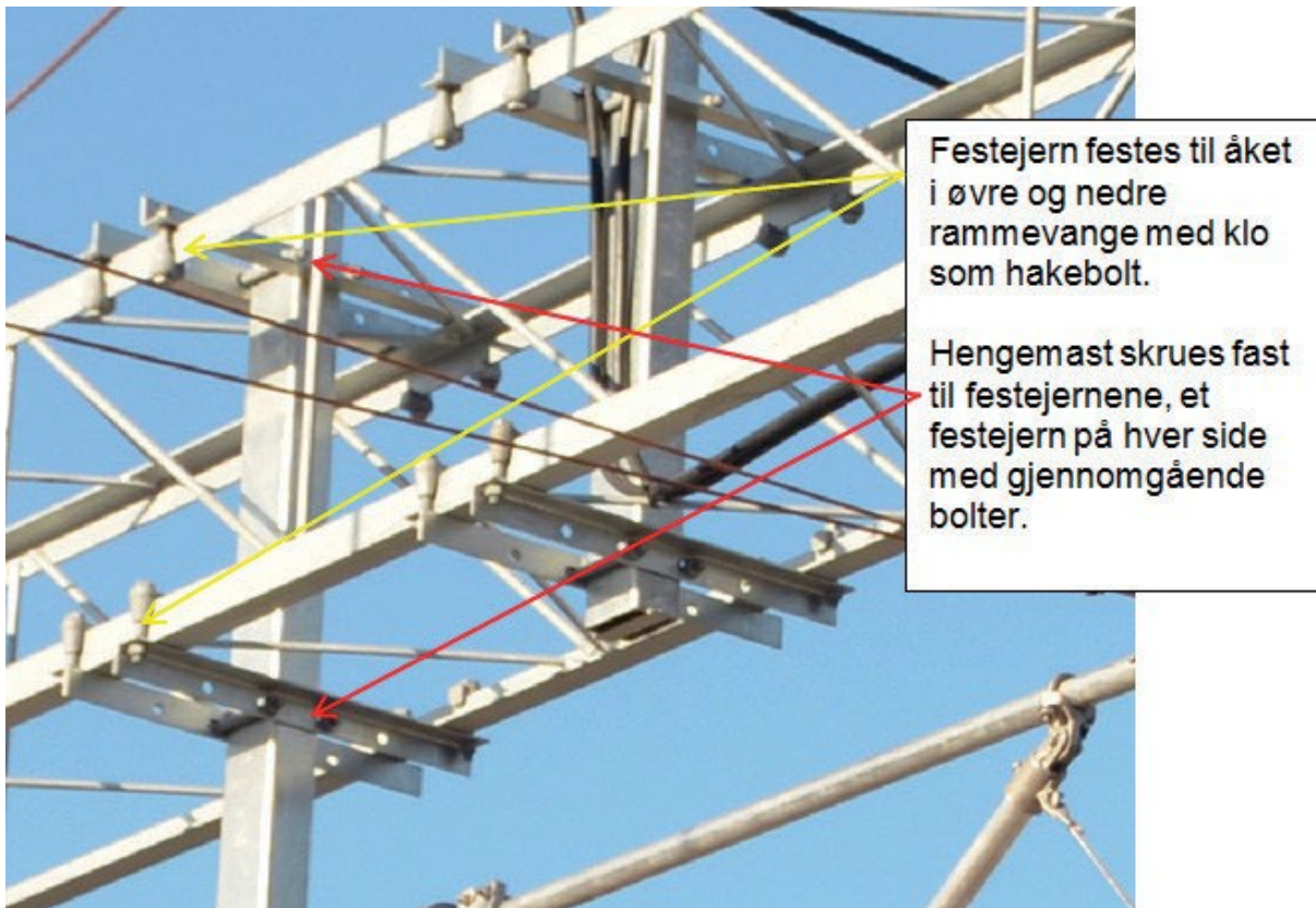
Figur 14.26 Montert hengemast og spir på åk
