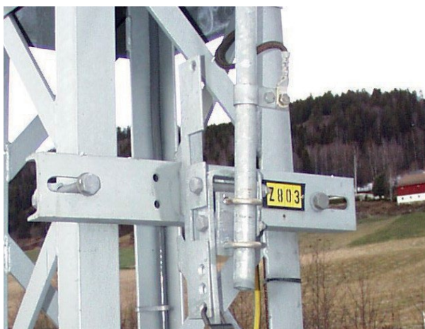
Figur 20.38 Utjevning av betjeningsrør til bryter
