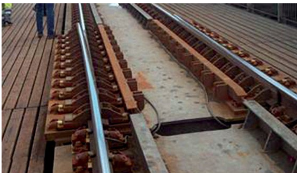
Figur 19.26 Glideskjøt med sporutvidelse
