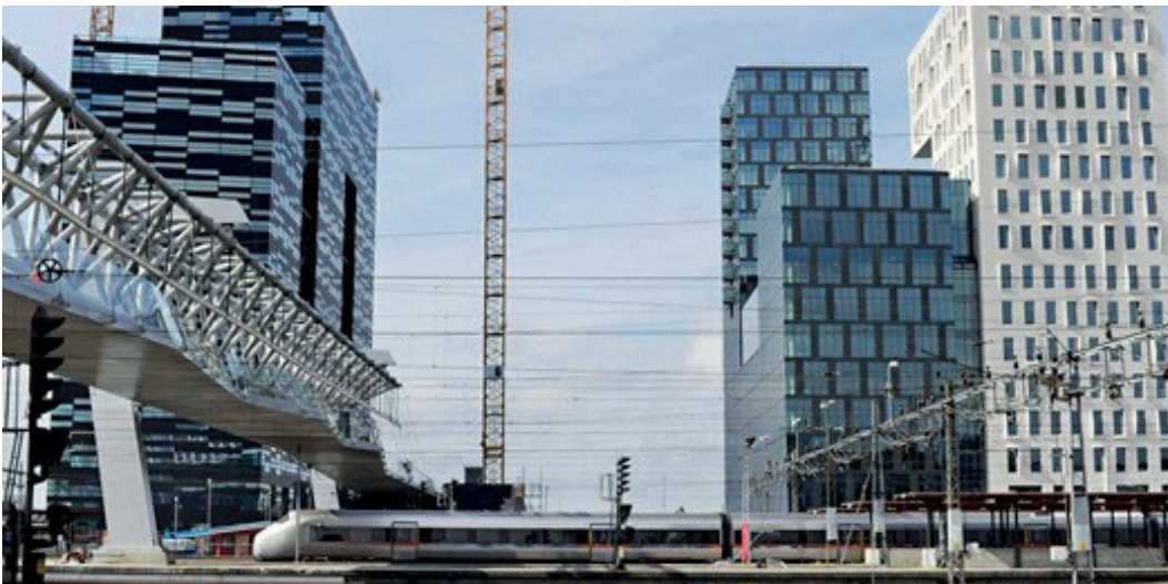
Figur 20.11 Den nye gangbroen over Oslo S
