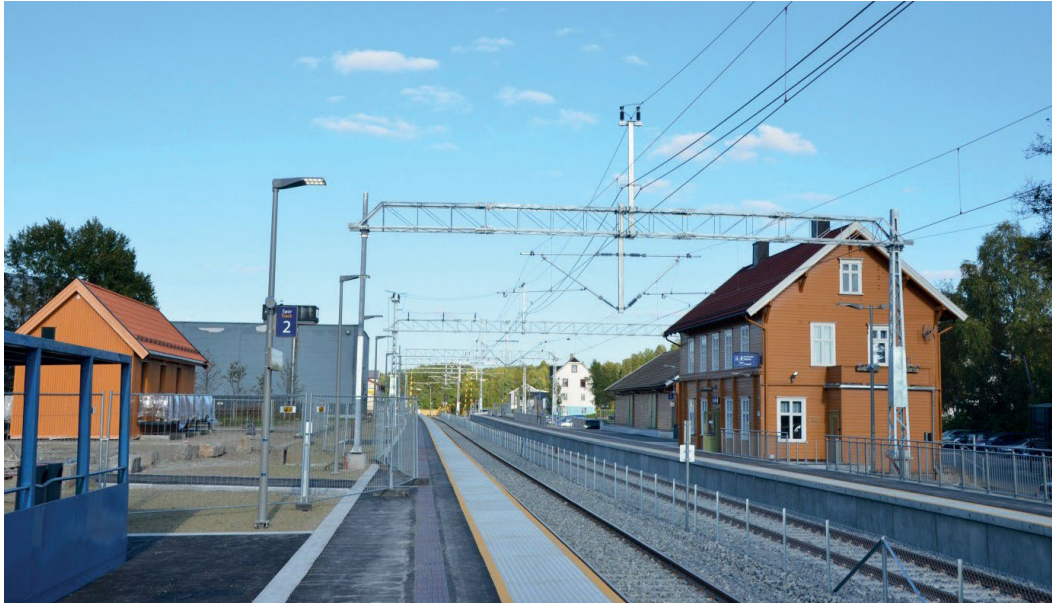
Figur 14.1 Åk montert på Spydeberg stasjon
