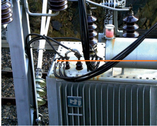
Figur 18.6 Merking på sugetransformator i mast
