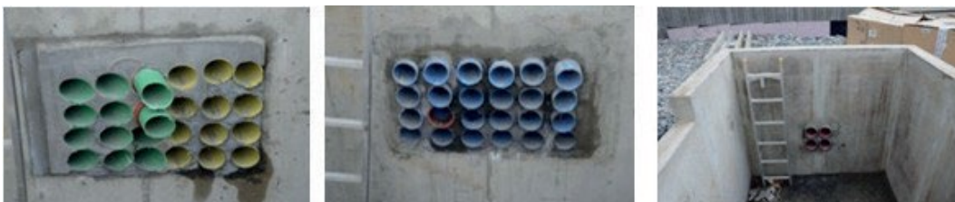
Figur 19.9 Eksempel på bruk av fargekoder ved rørgjennomføring til teknisk hus
