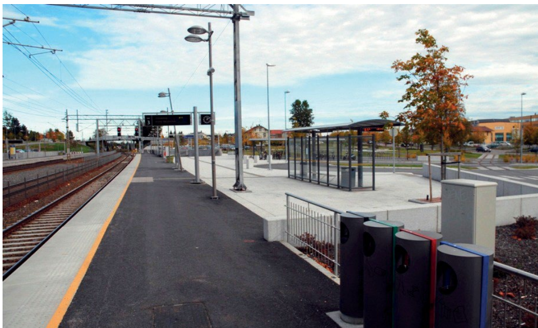
Figur 20.28 Lysmaster tilkoblet strøm fra el-verk benytter «åpen jording» til spor
