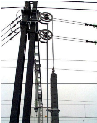
Figur 16.2 Loddavspenning med utveksling 1:3 med utvendig loddlineføring
