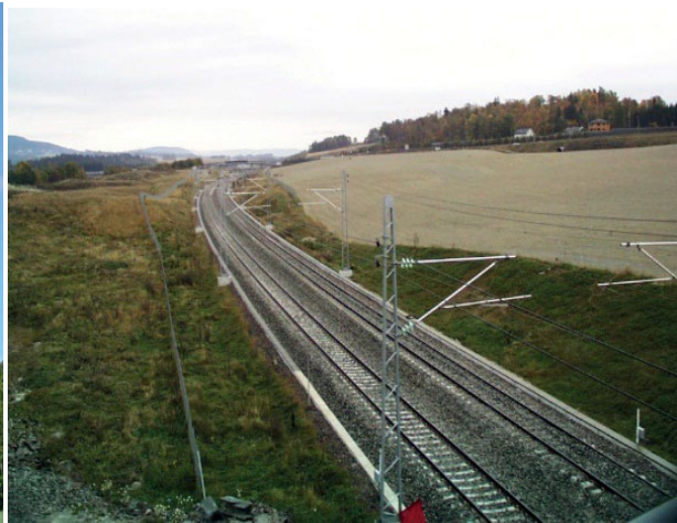
Figur 17.2 Strekning med nytt System 20
