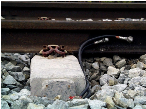
Figur 19.18 Kobling til jord/returstrømskinne med godkjent skrueforbindelse
