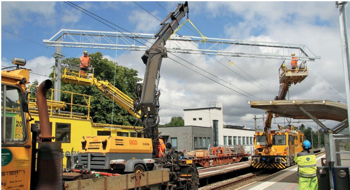
Figur 14.23 Heising av åk på granddal stasjon
