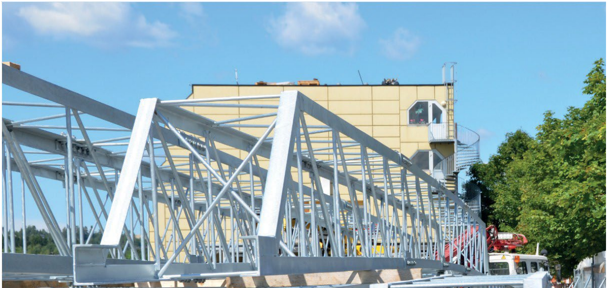
Figur 14.18 Lagring av åk. Legg merke til plankene som blir benyttet som beskyttelse
