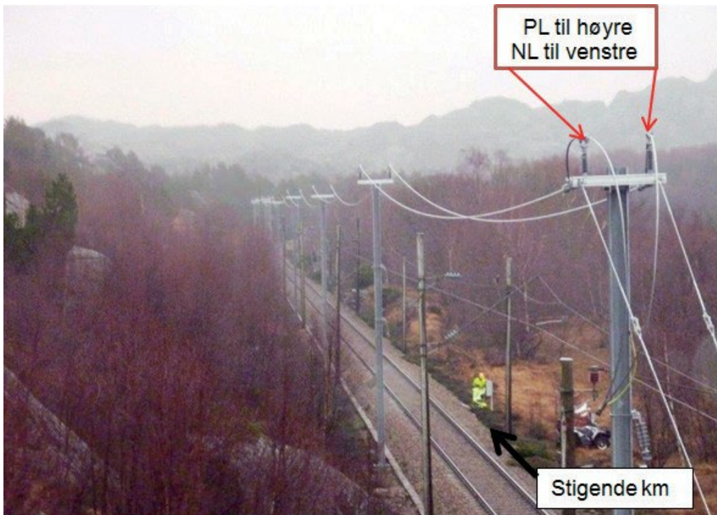
Figur 17.16 Plassering av AT-ledere
