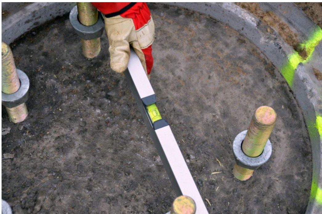
Figur 8.26 Vatring av underlagsmuttere på fundamentet
