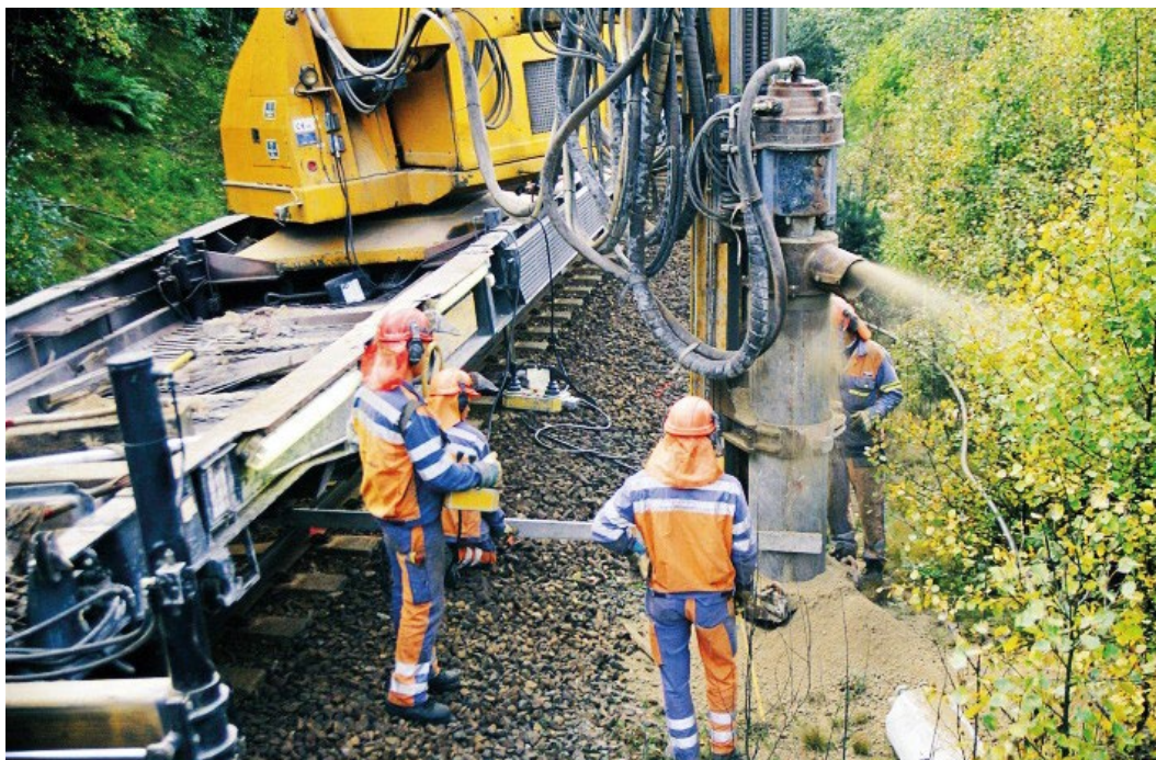
Figur 8.7 Boring av mastefundament
