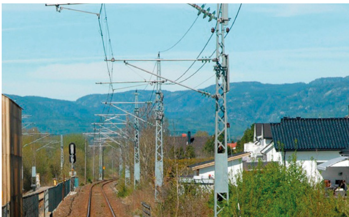
Figur 5.28 Bilde av kontaktrådens sikk-sakk i forhold til spormidtd
