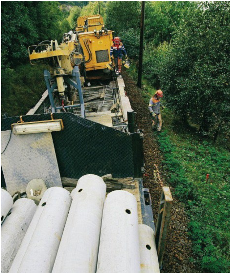
Figur 8.9 Utløp for gysemasse er de sorte merkene på fundamentene
