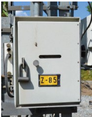
Figur 4.31 Manøvermaskin til fjernbetjent bryter
