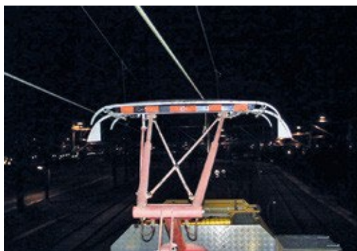
Figur 5.35 Feil påløp av ledninger
