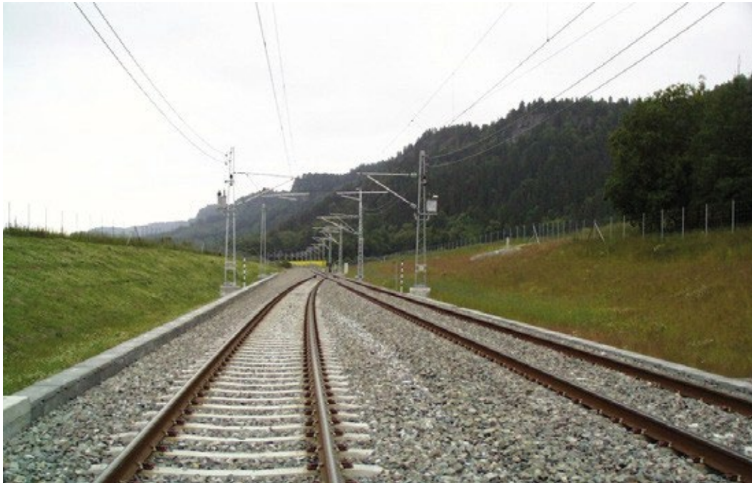
Figur 6.15 Ny parsell med System 20 kontaktledningsanlegg
