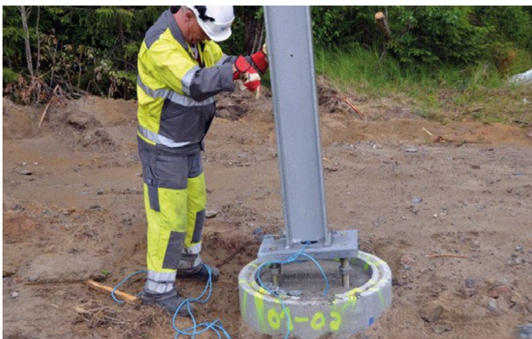
Figur 8.27 Masten settes ned på fundamentboltene
