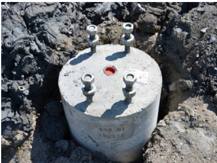
Figur 8.10 Mastefundamentet er låst fast i borehullet
