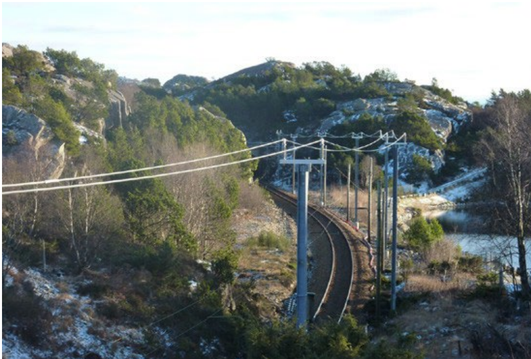
Figur 4.40 Strekking med AT-ledninger mellom Egersund og Hellvik
