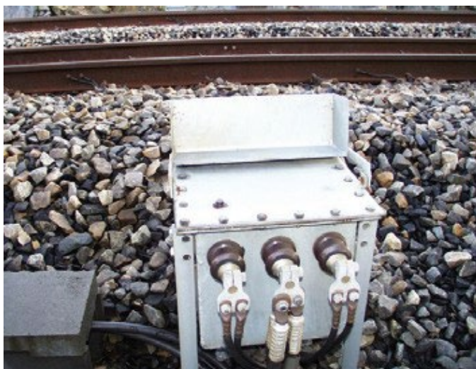
Figur 4.11 Filterimpedansens plassering ved sporet
