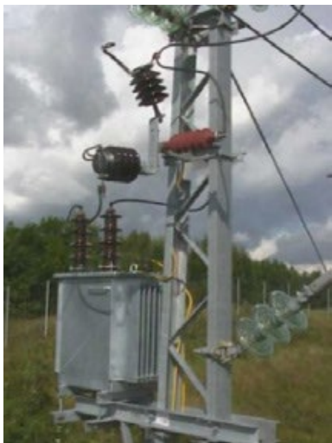
Figur 10.18 Reservestrømstransformator
