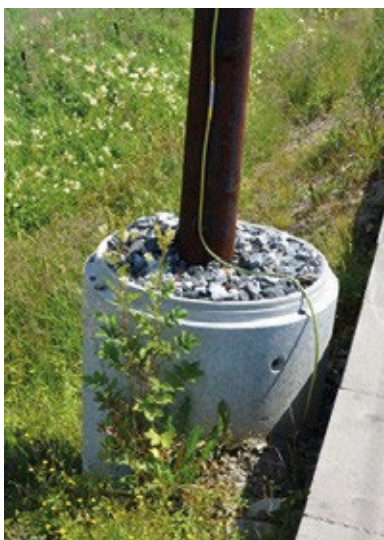
Figur 8.13 Midlertidig mast i kumring
