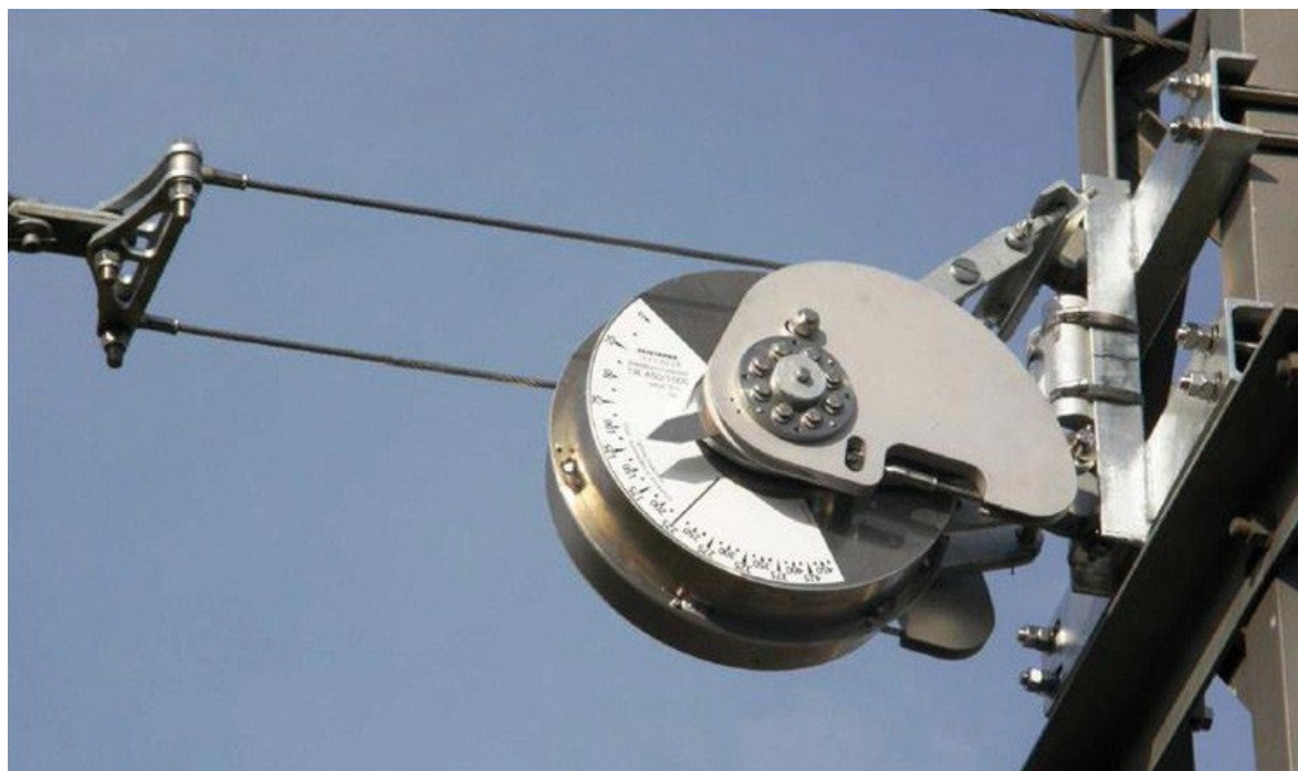
Figur 5.23 Den mest brukte fjæravspenningen i Bane NOR
