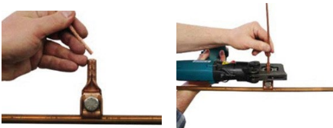
Figur 9.27 Pressing av tilpasset hengeråd
