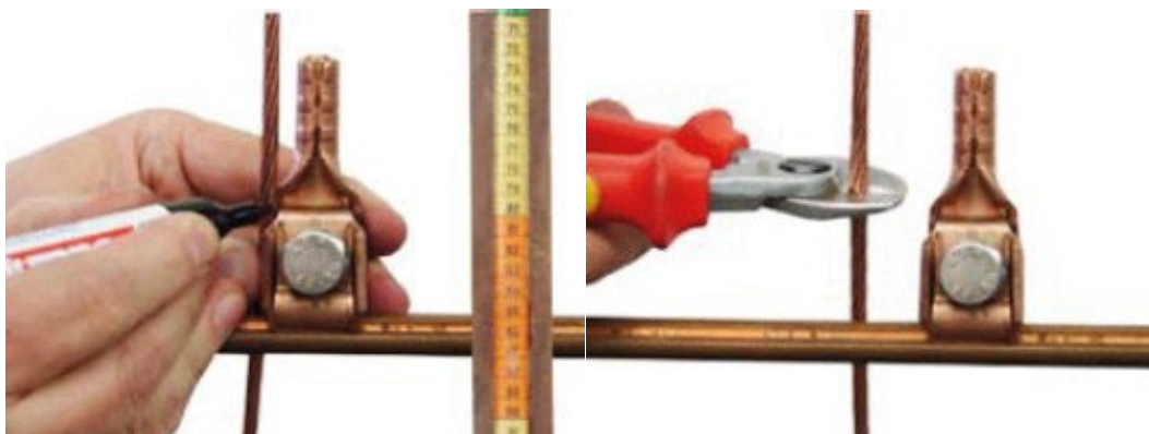
Figur 9.26 Tilpassing av hengeråd
