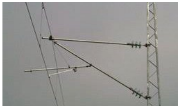
Figur 4.33 Isolatorer I utligger
