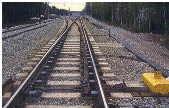
Figur 5.3 Skinner med spurveksel
