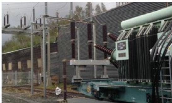
Figur 4.28 Effektbryter
