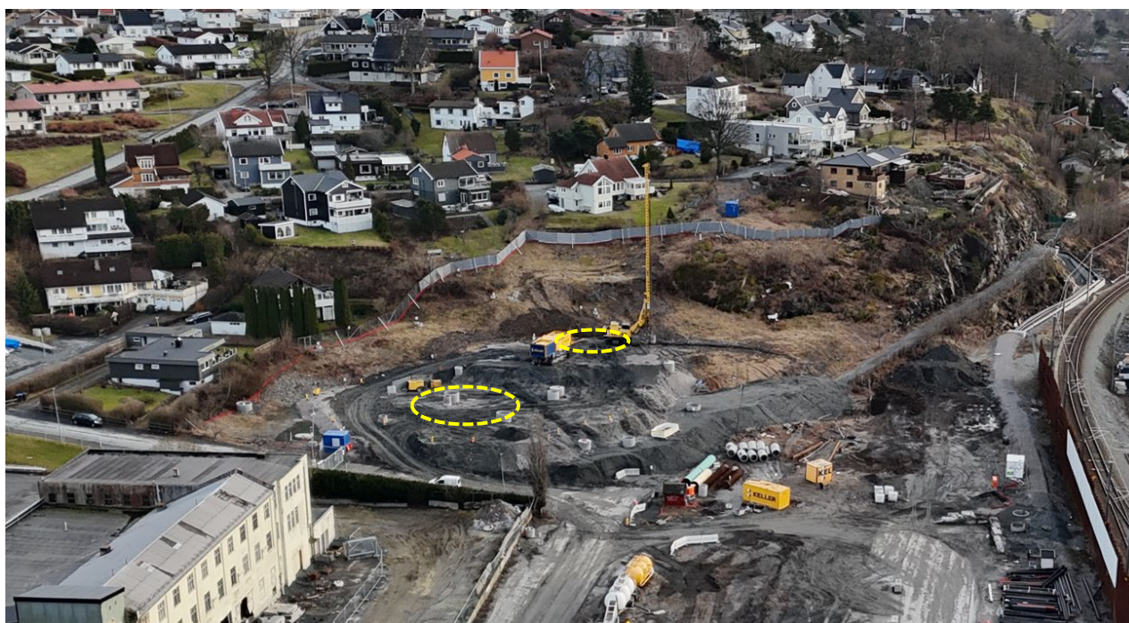
Figur 1. Område ved Kleberget hvor Bane NOR utfører grunnstabilisering. KlimaGrunn skal sette ned instrumenter omtrent innenfor gulmerkede områder. Foto: Bane NOR.
