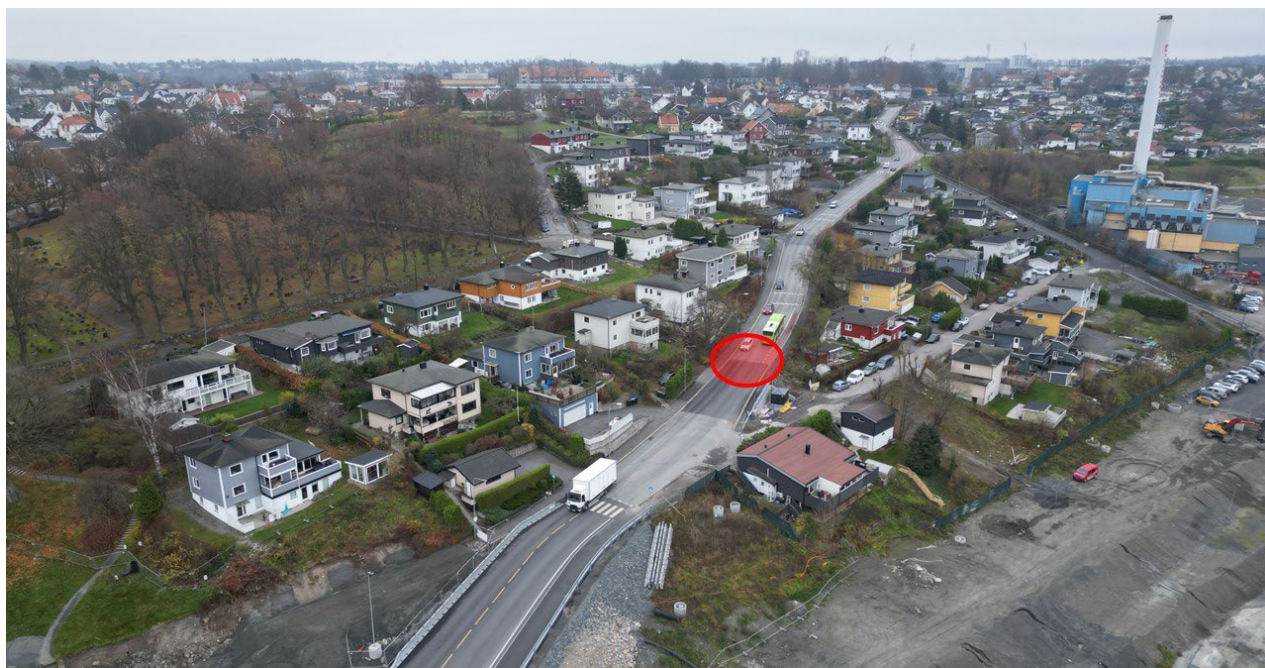
Arbeidet skal pågå i området ved den røde sirkelen. Foto: Bane NOR
