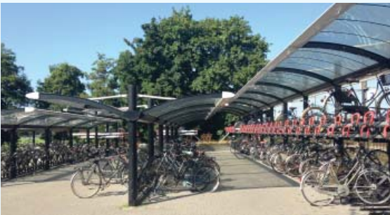
TO-HØYDE STATIVER NÆRMEST PLATTFORMEN
