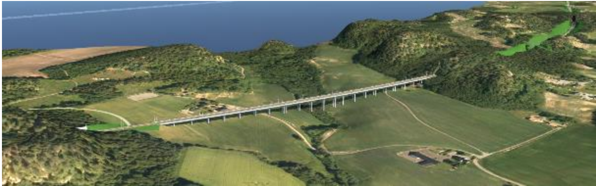
Figur 2-4 Linja i Torp vest-korridoren med åpen skjæring gjennom Stangeskogen og lang bru over Unnebergdalen. Sett fra sørøst mot nordvest.
