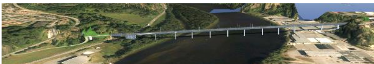
Figur 2-11 Dobbeltsporet krysser Lågen, Stålakerkorridoren. Sett fra sør.
