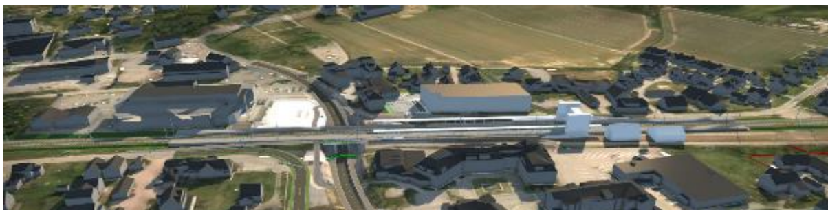
Figur 2-3 Stokke stasjon sett vest mot øst.
