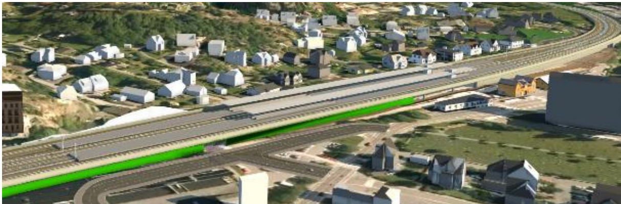
Figur 2-6 Sandefjord stasjon i Gokstadkorridoren, sett fra sørvest, retning Larvik mot venstre..
