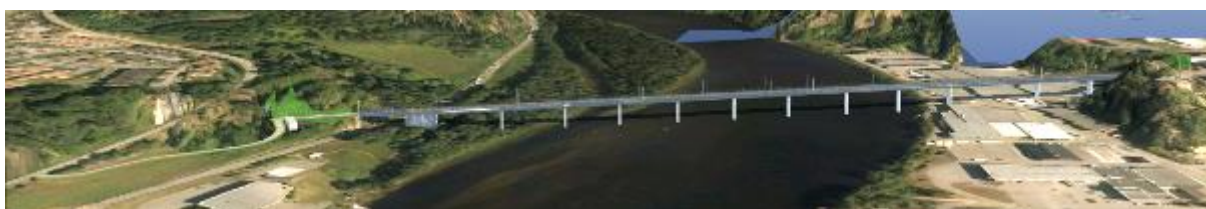
Figur 2-7 Dobbeltsporet krysser Lågen, Stålakerkorridoren. Sett fra sør, retning Larvik til venstre..
