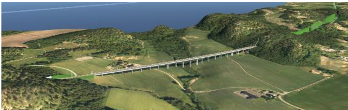
Figur 2-2 Torp vest-korridoren med åpen skjæring gjennom Stangeskogen og lang bru over Unnebergdalen. Sett fra sørøst, retning Sandefjord er mot venstre.
