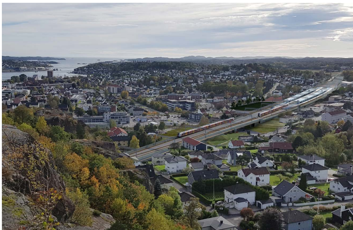
Figur 5-22. Nytt spor sett fra Mokollen. Sandefjordveien midt i bildet, ny stasjon til høyre. Fotomontasje basert på foreløpig tiltak.
