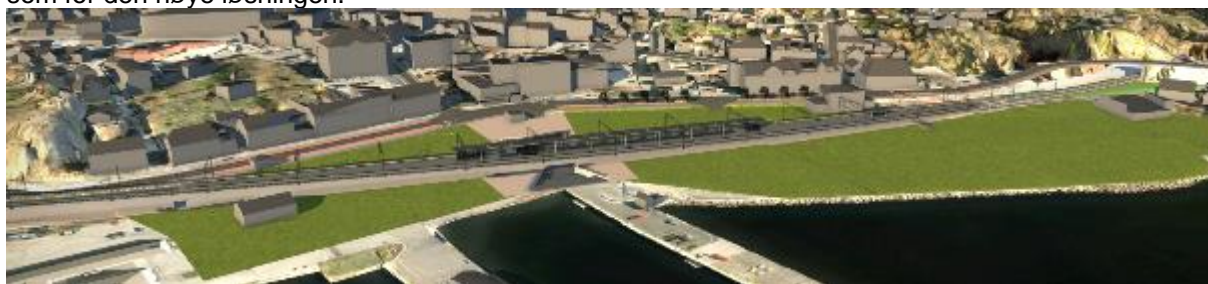
Figur 2-12 Indre havn lav sett fra sør, retning Kleivertunnelen mot venstre.
