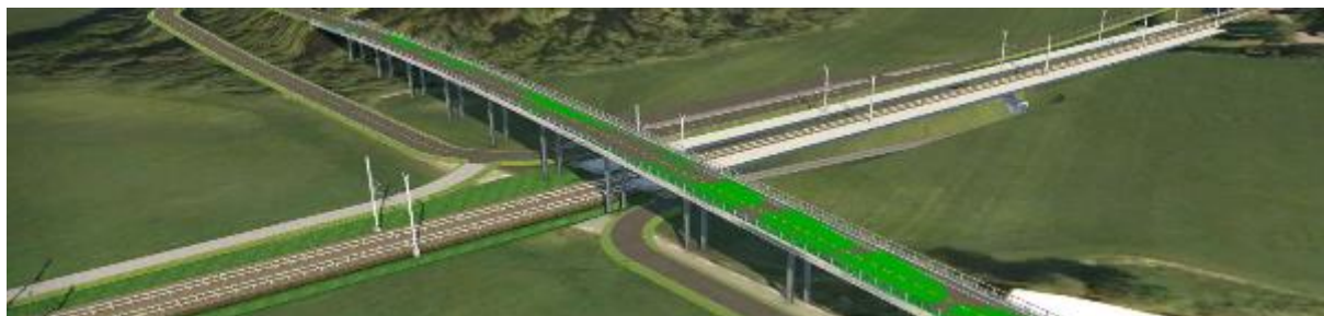
Figur 2-5 Ny Torp stasjon i Unnebergkorridoren, på vestsiden av nytt dobbeltspor, retning Sandefjord mot venstre.
