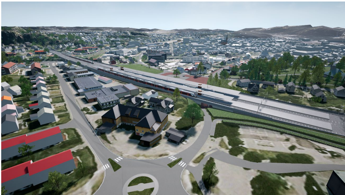
Figur 8-5 Sandefjord stasjon i Torp vest- og Unnebergkorridoren. Sporene går i retning Oslo mot venstre. Nytt dobbeltspor og plattformer med takoverbygg sees midt i bildet. Forlengelsen av Bugårdsgata er vist som en undergang for gående og syklende under sporene. Kilde: Stasjonsmodellene for Sandefjord stasjon i Gokstadkorridoren, utarbeidet av NOAV for Bane NOR.
