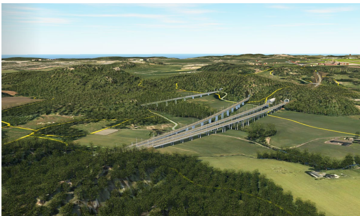
Figur 3-5 Modellbilde som viser hvordan alternativene krysser Unnebergdalen; Torp vest via Storås lengst inne i dalen, Torp vest revidert(250/200) i midten med (200) lengst til venstre og Torp vest lengst til høyre i bildet. Bildet er sett fra sør mot nord.
