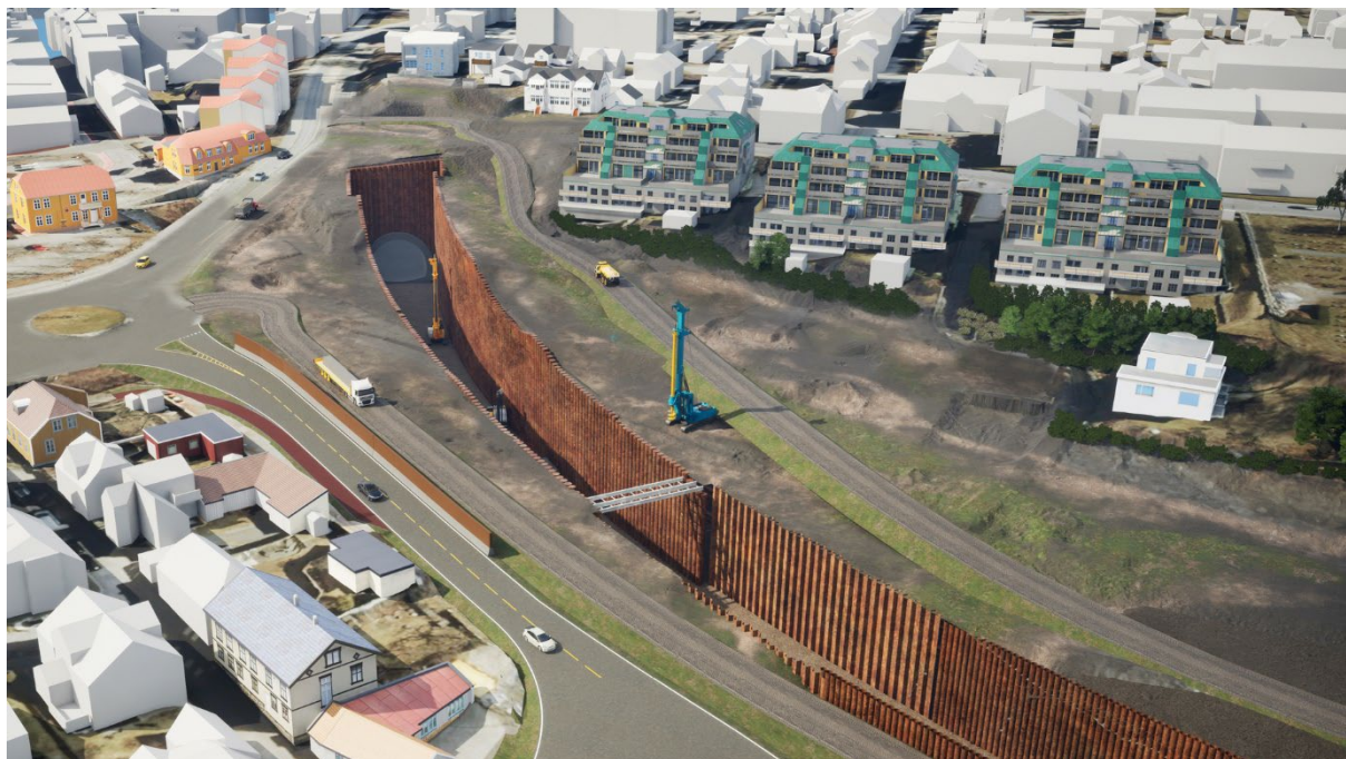
Figur 3-5: Illustrasjon av byggegrop. Stivere fjernet for å visualisere dybde.
