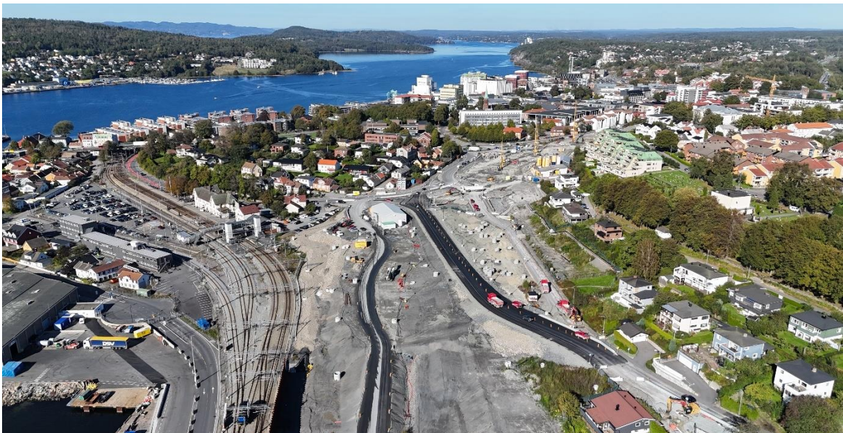
Figur 8: Figuren viser den sentrale delen av planområdet. Moss jernbanestasjon ligger til venstre for anleggsområdet.
