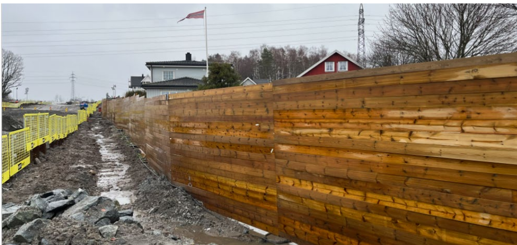
Figur 16. Det er etablert en støyskerm mot naboene i Larkollveien. Foto: Bane NOR.
