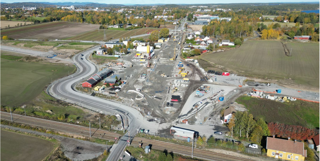
Figur 6. Larkollveien ved kryssing av nytt dobbeltspor, like ved Dilling. Spunt er satt og det pågår grunnstabilisering. Foto: Bane NOR.
