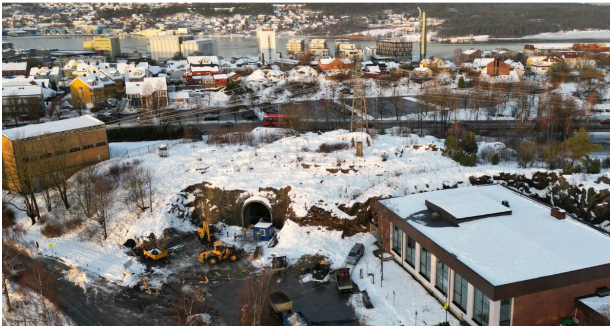
Figur 3. Rømningstunnelen fra Mossetunnelen kommer opp ved Mossehallen. Foto: Bane NOR.
