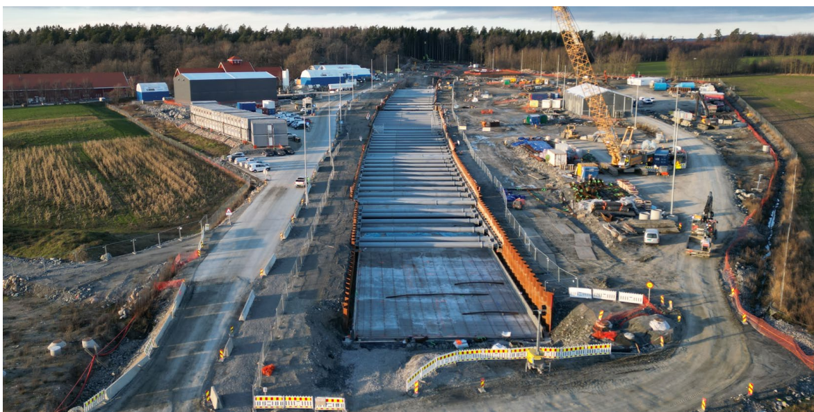
Figur 5. Kulvert Carlberg, som fører inn mot ny tunnel. Foto: Bane NOR.
