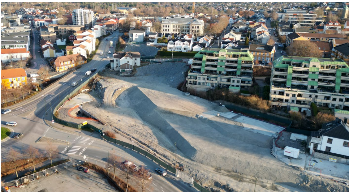
Figur 4. Motfylling Kransen Nord er etablert som er områdestabiliseringstiltak. Foto: Bane NOR.
